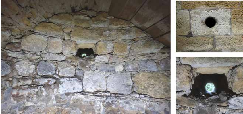
Abb. 10: Kärntner Hartberg, Untergeschoß Apsis, Oculus von außen und innen (Durchmesser Oculus 13 cm, Höhe über Gelände 1.06 m, Werkstein wie Bandrippen). Im unteren Bildteil ist eine Arbeitsfuge („ausgezwickelte“ Schar) erkennbar; unterhalb ist das Mauerwerk verputzt (vgl. Abb. 9) und oberhalb steinsichtig. Die Schalungsbretter des Tonnengewölbes sind zum Teil noch vorhanden (linkes Bild, rechts oben).
