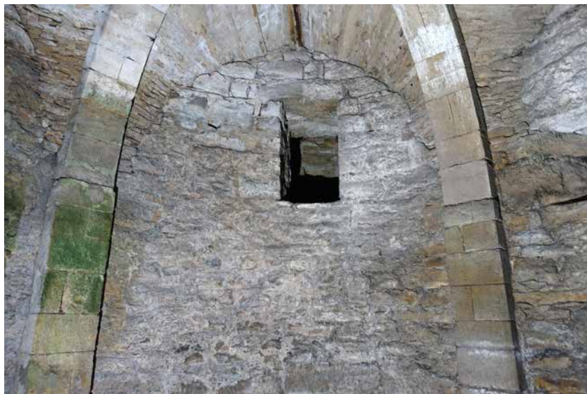
Abb. 8: Karner Hartberg, Ossarium, Ansicht nach Osten, Zwischenwand. Ossarium-Untergeschoß Apsis mit Durchstieg (0.80 x 1.55 m, Wanddicke 1.35 m).
