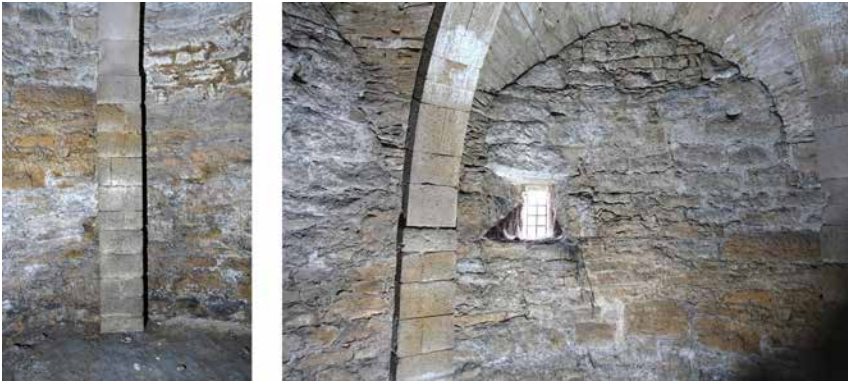
Abb. 6: Karner Hartberg, Ossarium, Wandpfeiler mit Gewölbeansatz (Ansicht nach Süden). Wechsel in der Breite beim Übergang Pfeiler zum Gewölbe von 55 cm auf ca. 50 cm (Bandrippen) und im Steinmaterial. Höhe der Änderung ca. 3.1 m über Fußboden, etwa Unterkante Fenster.
