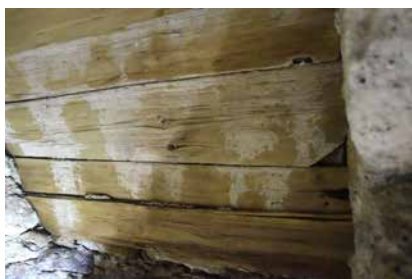
Abb. 33: Karner Hartberg, Schalungsbretter des Schüttgewölbes über dem Untergeschoß Apsis.
