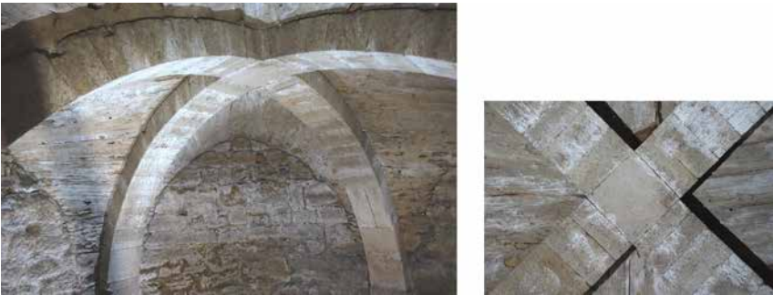
Abb. 7: Karner Hartberg, Ossarium, Bandrippen mit Schüttgewölbe und quadratischem Schlussstein. Raumhöhe bis Schlussstein ca. 6.0 m über dem derzeitigen Fußbodenniveau.
