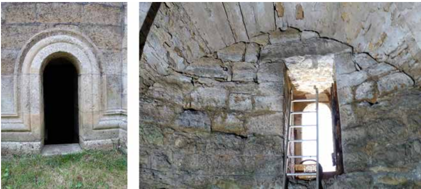
Abb. 5: Karner Hartberg, Einstieg in das Ossarium von außen und innen. Lichte Weite außen 52 cm und innen 77 cm, Mauerdicke 1.39 m.
